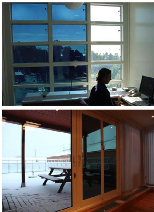
Figura 2. Instalações testes de dois exemplos de janelas inteligentes eletrocromicas. Reprodução da ref. 10 com autorização. Copyright© 2014 Elsevier, U.K.
