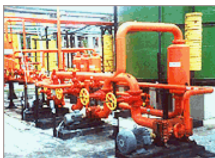
Figura 5. Captação de cloro gasoso proveniente da produção eletrolítica via células de mercúrio (Araripe, Igarassu – PE) 17
